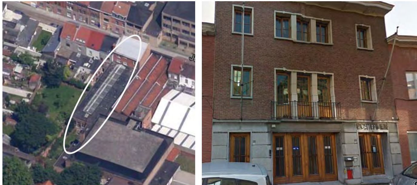
Links het vroegere postgebouw en rechts het zicht op de voorgevel van het vroegere postgebouw
