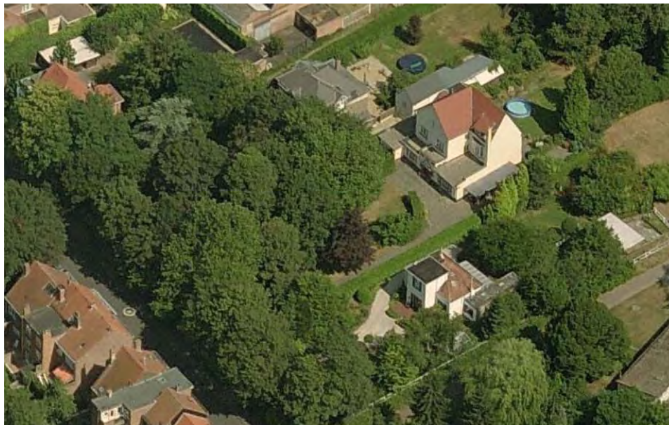
Luchtfoto van voor de afbraak van de villa onderaan
