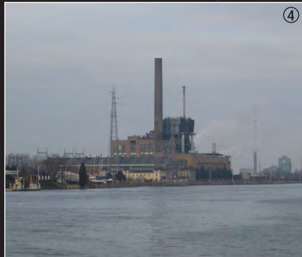
Installatie en schoorsteen van de voormalige elektriciteitscentrale van Langerbrugge
