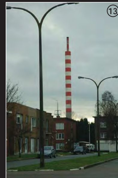
Schoorsteen aan de gipsberg
