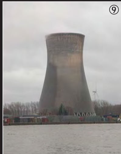
Koeltoren van de elektriciteitscentrale van Rodenhuize
