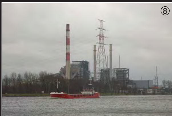
Installatie en schoorstenen van de elektriciteitscentrale van Rodenhuize
