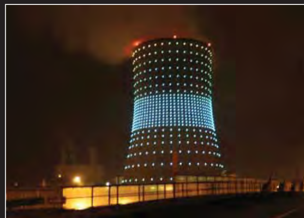
Koeltoren Electrabel Brussel – foto John Ess
