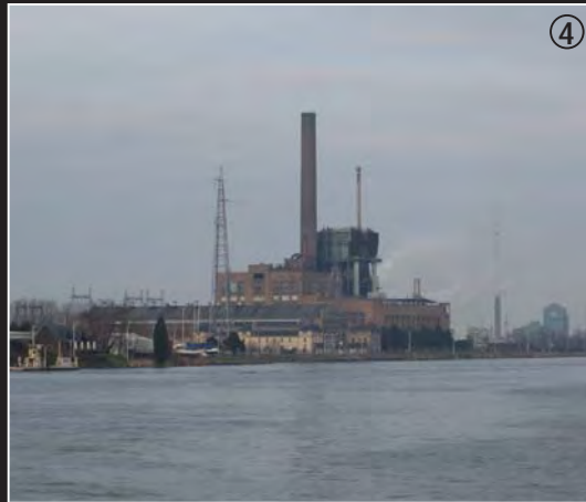
Schoorsteen van de voormalige elektriciteitscentrale van Langerbrugge
