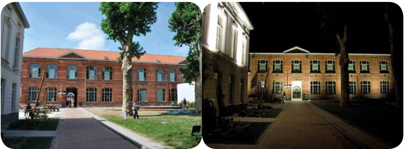
Pierkespark, een secundaire wijkkern in de Brugse Poort
