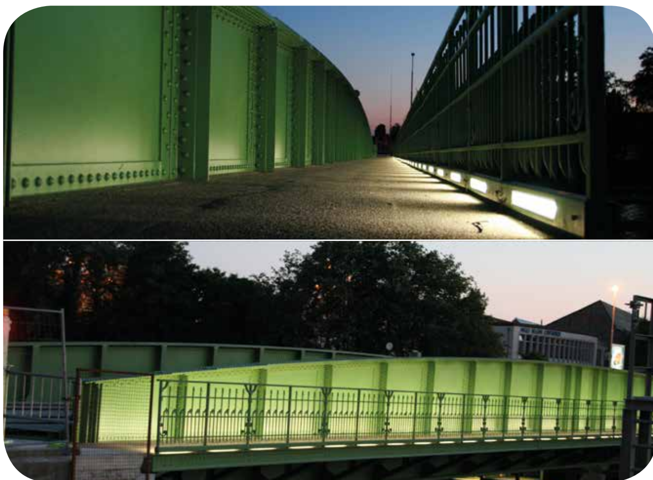
Spoorwegbrug Wiedauwkaai met LED-verlichting
