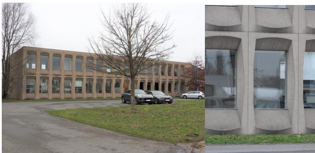
Figuur 10-1: Gevel van het Mecra Metam Corporation NV kantoorgebouw. (Rechts): ramen van het kantoorgebouw
