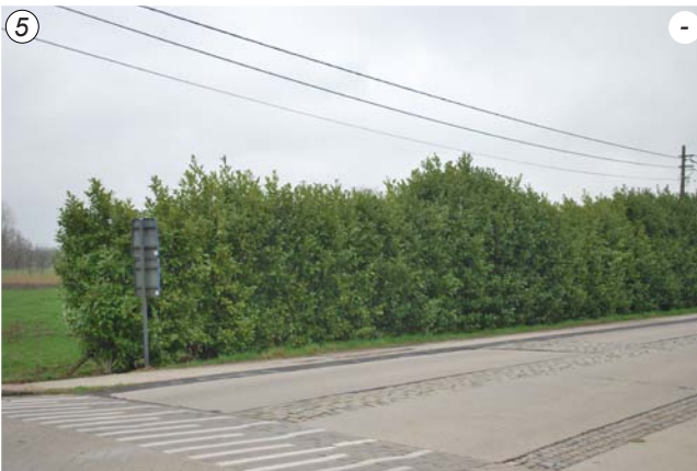
niet overkijkbare groenaanleg langs de weg
