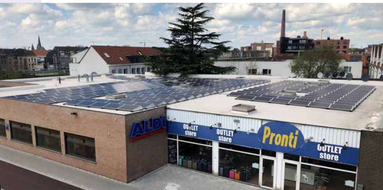
De grootste installatie die Buurzame Stroom plaatste. Energent investeerde in de zonnepanelen en verkoopt nu stroom aan een lage prijs aan de Aldi supermarkt.
