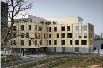
Op The Loop werd een nieuw gebouw in gebruik genomen. © Fluvius SINT-SCHUIS-WESTREM - Sinds begin deze maand is Fluvius verhuisd vanuit het vertrouwde kantoorgebouw aan de Bomastraat naar een nieuwbouw op The Loop. Alle 235 medewerkers uit de regio Gent werken voortaan daar, en ook klanten kunnen er terecht.
