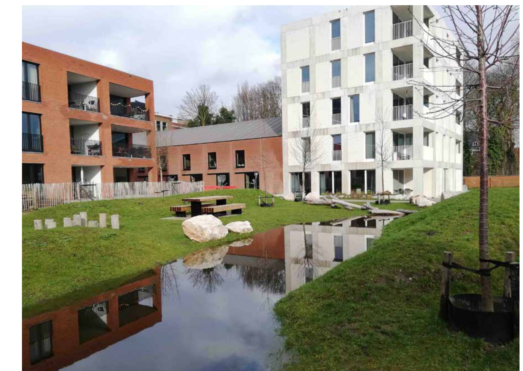
Dit is een voorbeeld van een wadi in de speelvallei, dit dient om overvloedig water op te vangen na een hevige regenbui
