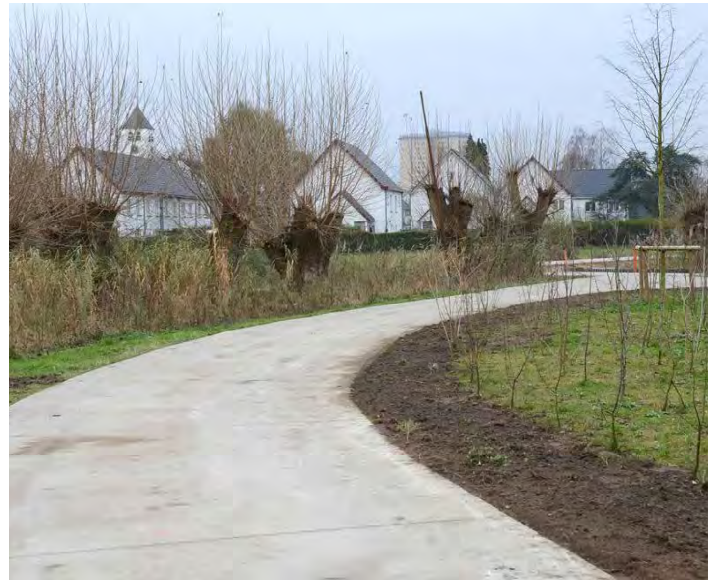
Praktijkvoorbeeld -Nieuw fietspad ingehuldigd tussen Drongensesteenweg, Malem en Noorderlaan
