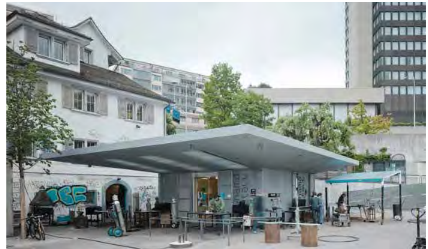
Praktijkvoorbeeld - Metal workshop Dynamo in Zürich, ontworpen door Phalt architecten.
