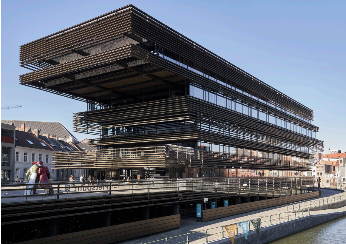
Bibliotheek de Krok, waar verwarmd wordt via een BEO-veld.
