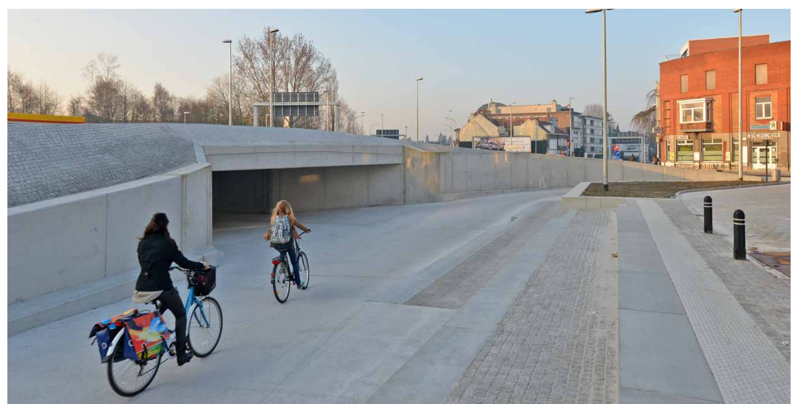
Fietstunnel aan de Sterre
