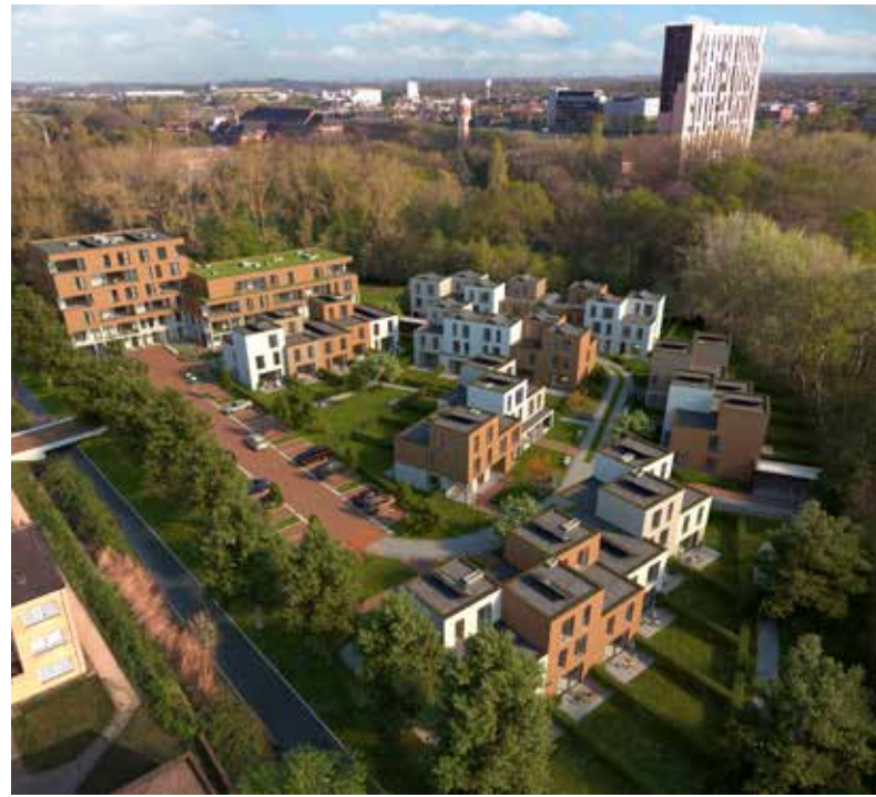
Simulatie van het nieuwbouwproject. Links zie je de Leebeek en de brug naar de Smaragdstraat.
