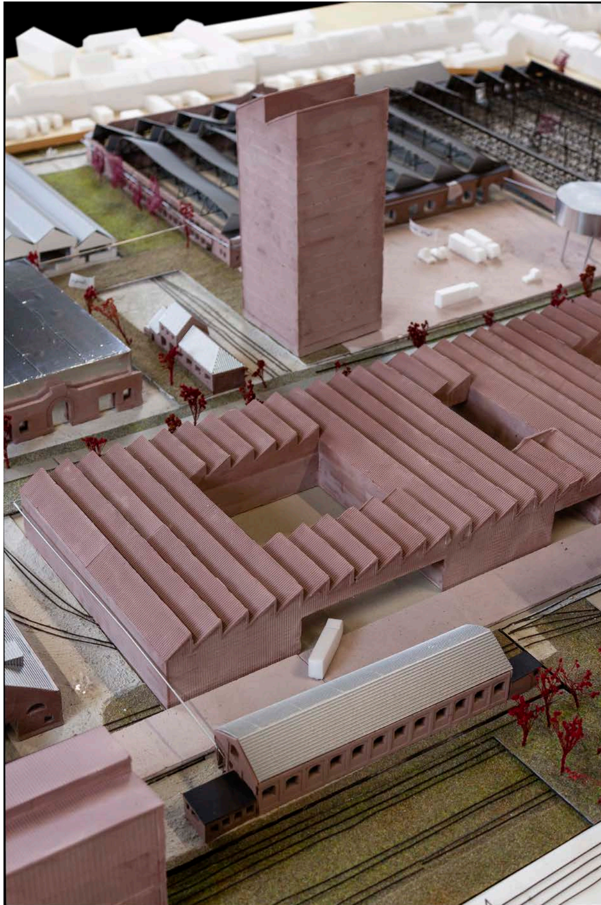
De Makershallen - een compact grootschalig gebouw van gestapelde, koppelbare KMO unit's - worden voor zwaar vrachtvervoer ontsloten langs twee patio's. Elke deel van de hallen is veilig te bereiken voor voetgangers en fietsers vanop de Arsenaal-as en via een centrale, kleinere patio.
