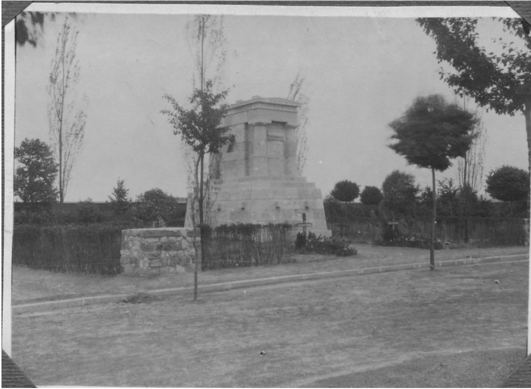
Situatie 1917. Voor het zeppelinmonument staan de twee kruisjes met beplante graftuin van Van der Haegen en Ackermann. Aan weerszijden zijn vijf andere bemanningsleden begraven. Zicht op de laan die beplant is met berken. "Zeppelindenkmal westfriedhof Gent, 1917". (Volksbund Deutsche Kriegsgräberfürsorge).
