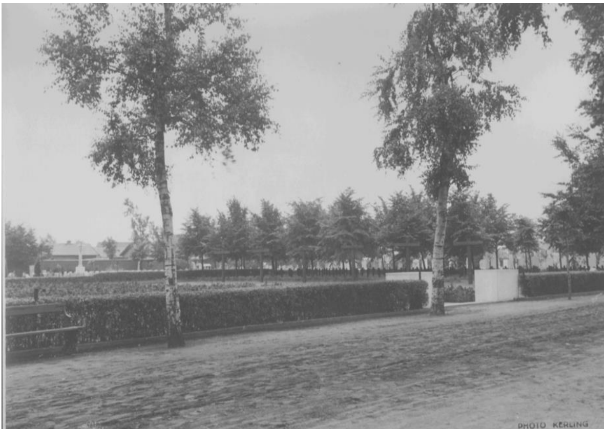
Situatie Gent 1 in 1930. Het Britse Cross of Sacrifice staat helemaal links op de foto. Rechts daarvan staat een rij grote houten kruisen- typerend voor Duitse begraafplaatsen – met daarachter rijen kruisen op graven van Duitse militairen. Het gehele militaire perk is omhaagd. De toegang is geaccentueerd door stenen muren. De laan is niet versteend en voorzien van berken. Links op de foto is een deel van een bank te zien. (Foto Volksbund Deutsche Kriegsgräberfürsorge).
