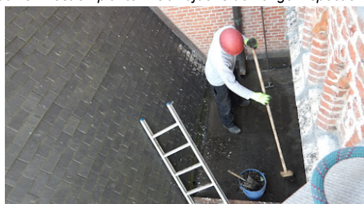
Periodiek reinigen van het dak en de bakgoot is sterk aanbevolen.
