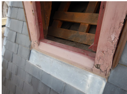
Gebarsten schilderwerk met beginnende inrotting tot gevolg.
