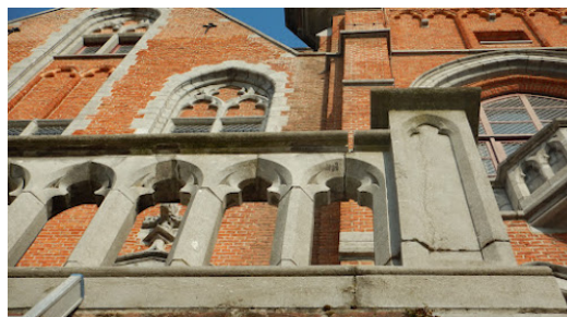
→ Detail weggevallen voeg thv de borstwering.
