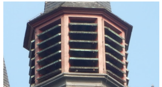
Verweerd schilderwerk thv de galmgaten in de toren.
